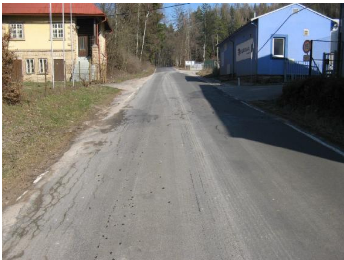
F20, km 0,960+ Vlevo síťové trhliny.
