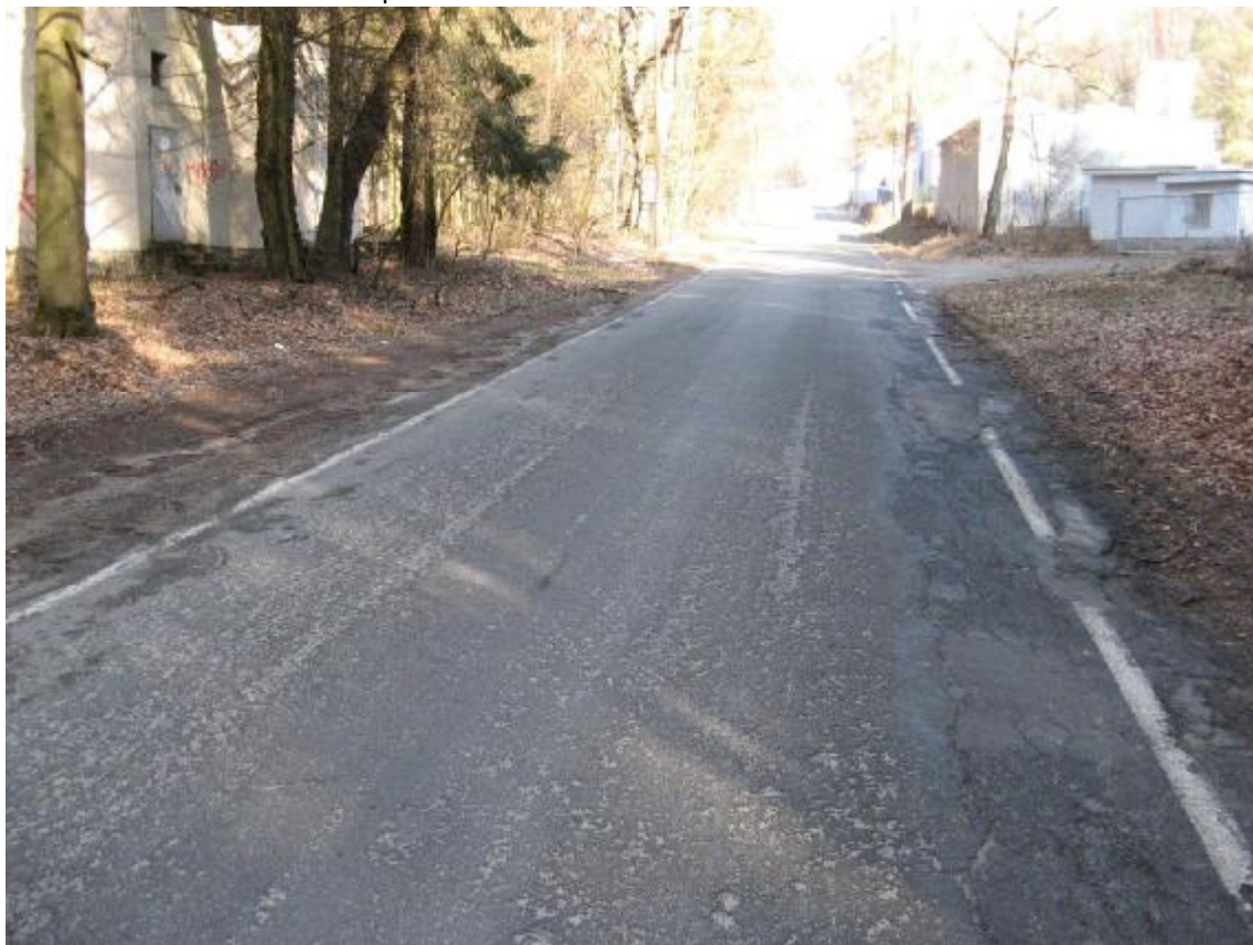
F18, km 0,860+ Koroze EKZ, vpravo síťové trhliny.
