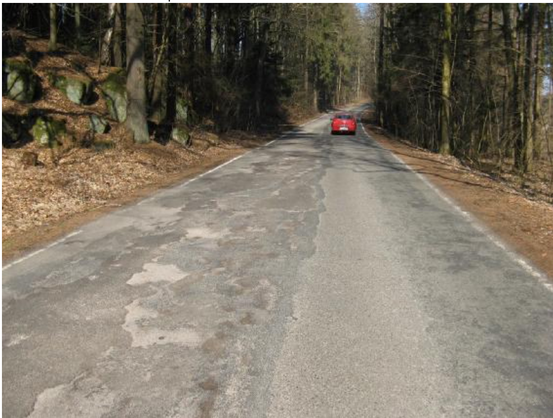
F38, km 1,610+ Nepravidelné hrboly tvořené vysprávkami.
