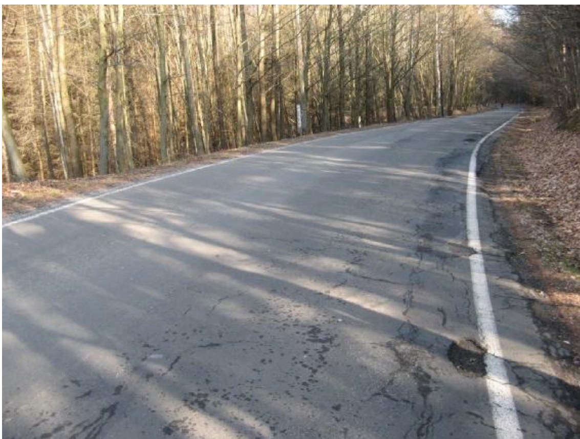
F12, km 0,610+ Síťové trhliny a výtluky podél okraje vozovky.
